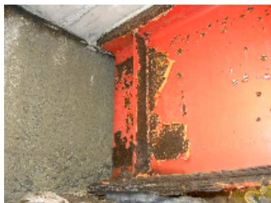
主桁腐食
