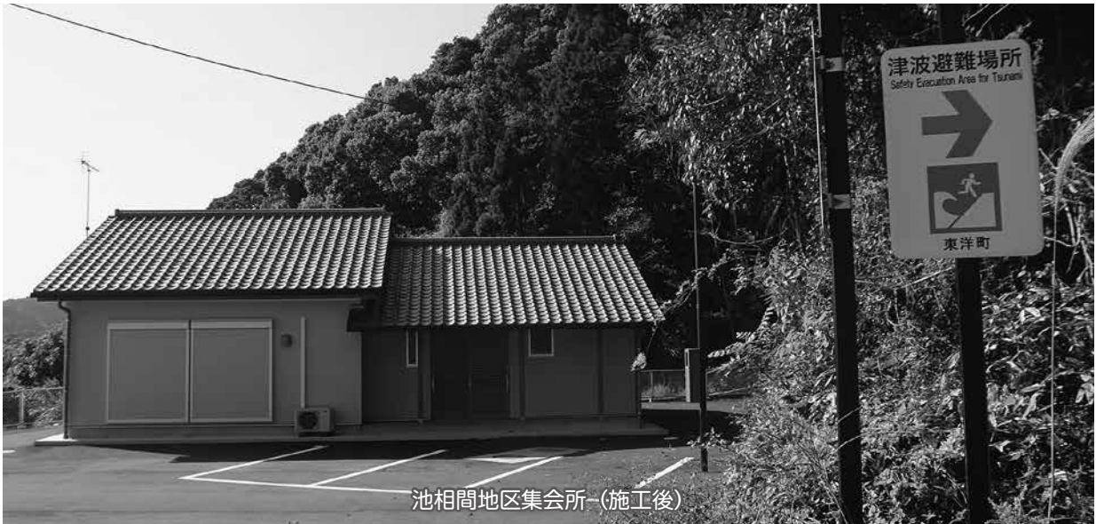
池相間地区集会所（施工前）
