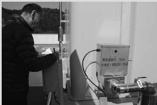
高架水槽の確認
