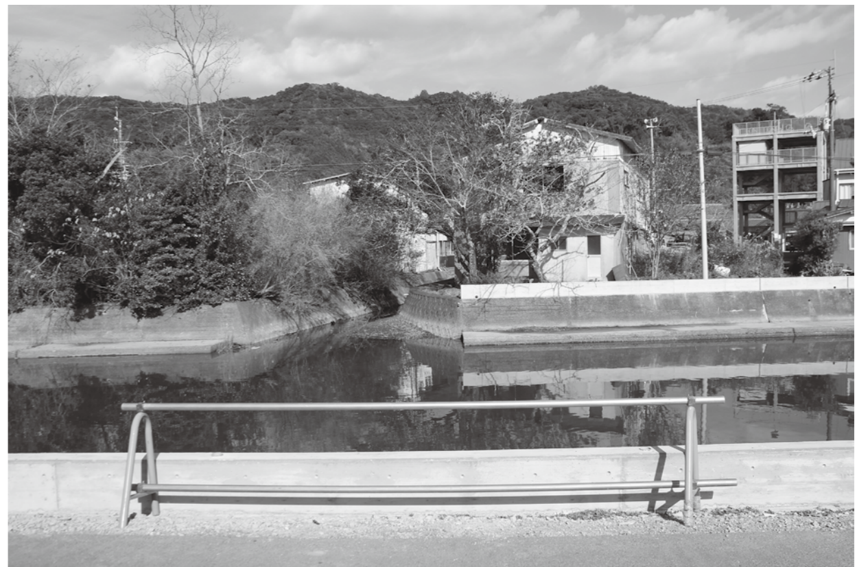
小池川のかさ上げ工事
