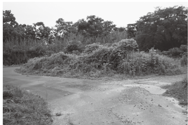
写真右がへりポートへの進入路だが、未舗装である。
