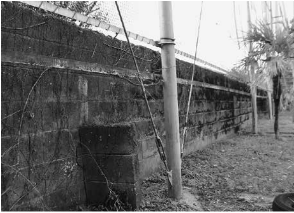
甲浦中グラウンドのブロック塀
