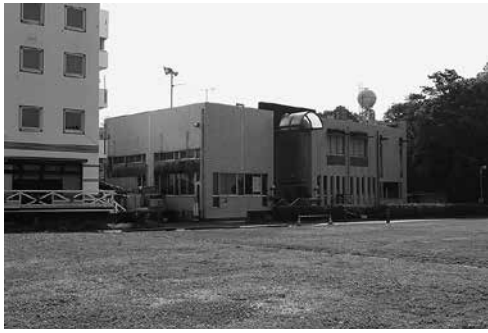
自然休養村 温浴施設
