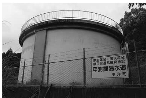
甲浦貯水タンク
