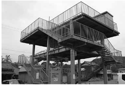
白浜地区第1防災避難タワー
