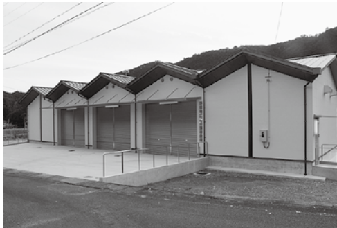
野根地区防災備蓄倉庫
