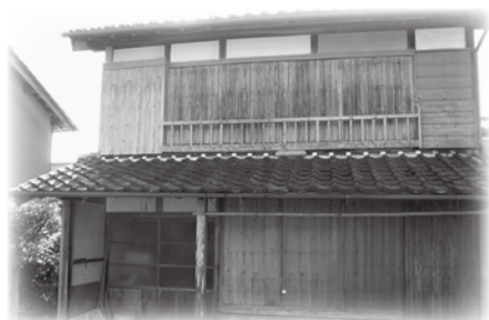
移住住宅（施工前）
