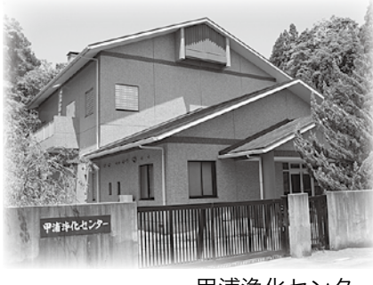
甲浦浄化センター
