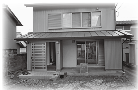
移住住宅（施工後）
