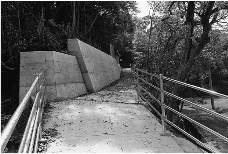
津波避難路整備工事
