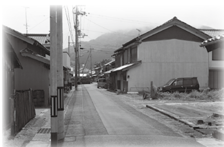
町道改良工事
