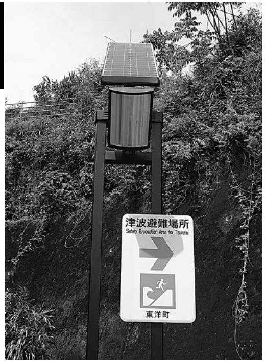
津波避難誘導灯設置工事
