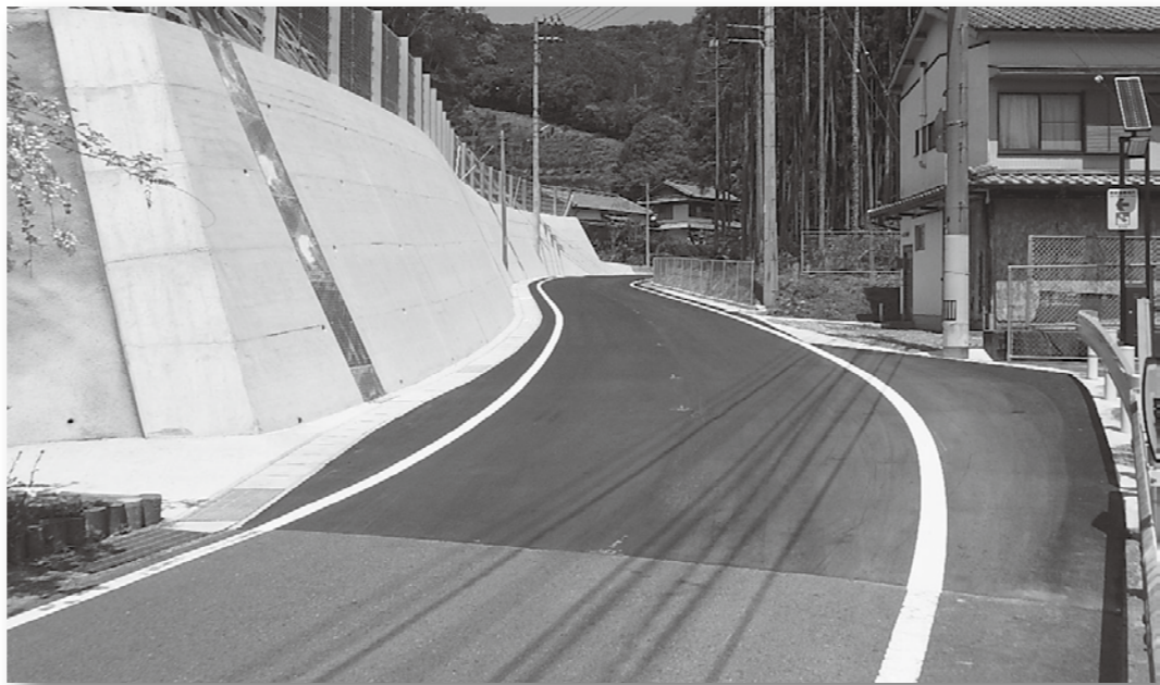
町道甲浦1号幹線 (施工後)
