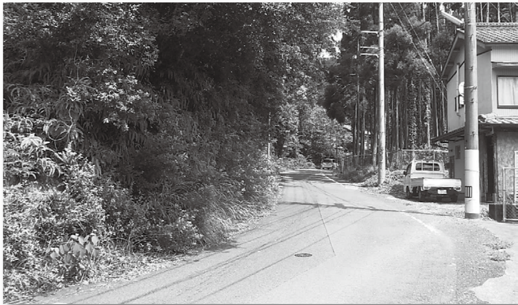
町道甲浦1号幹線 (施工前)
