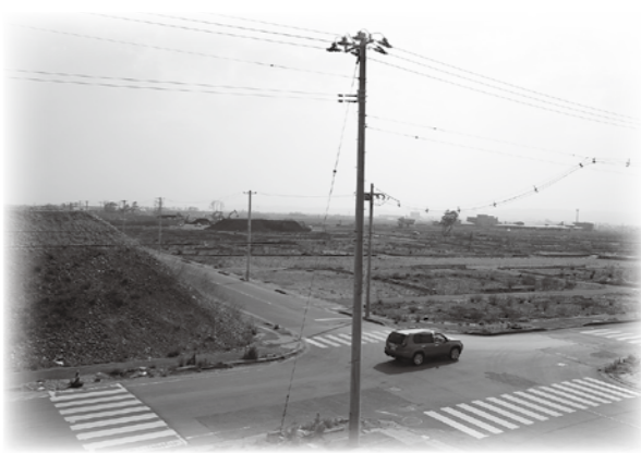
東日本大震災の津波で住宅が壊滅した宮城県名取市関上地区
