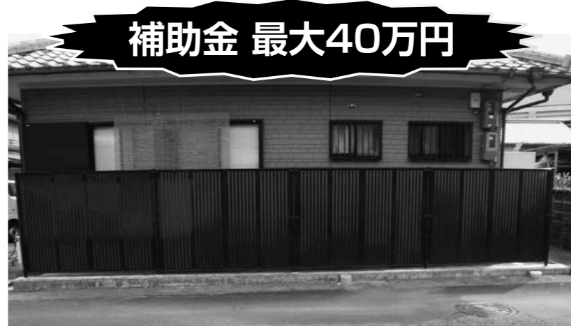
撤去後にフェンスを設置した事例
