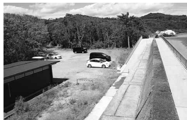
生見サーフィンビーチへ新たな駐車場を整備
