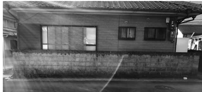
コンクリートブロック撤去前
