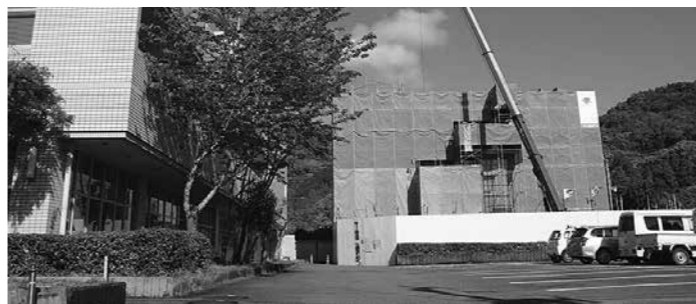
庁舎横に、防災センター建設中
