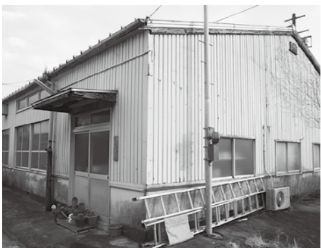
取壊された縫製関係等共同作業場
