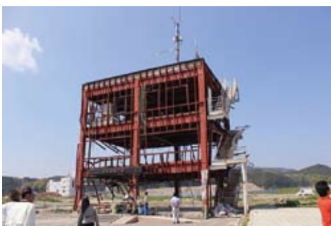
南三陸町 防災庁舎屋上ポールまで津波来襲
