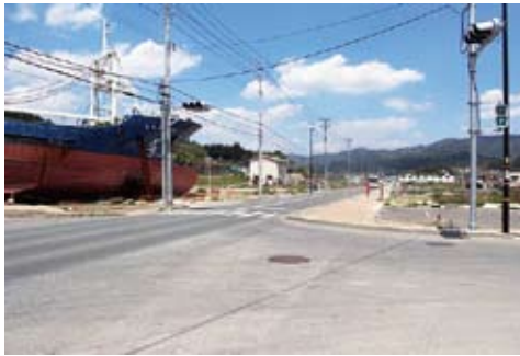
気仙沼市 冠水するため道路かさ上げ
