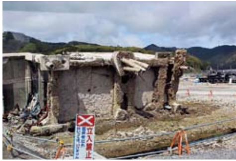
東北被災研修 女川町 市街3階建て倒壊
