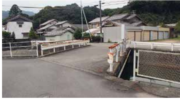
小池中橋 耐震化予定
