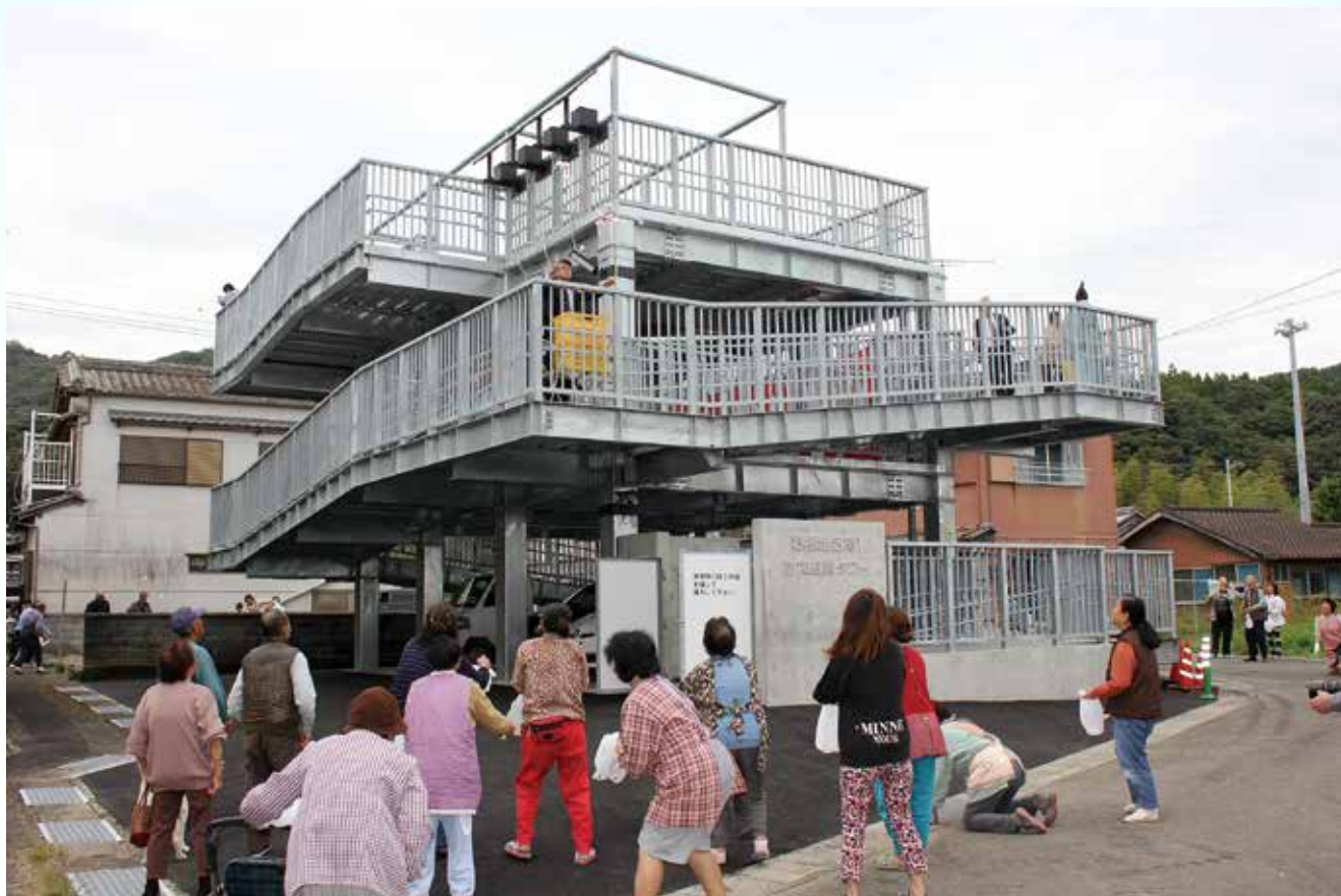
野根地区避難タワー完成
