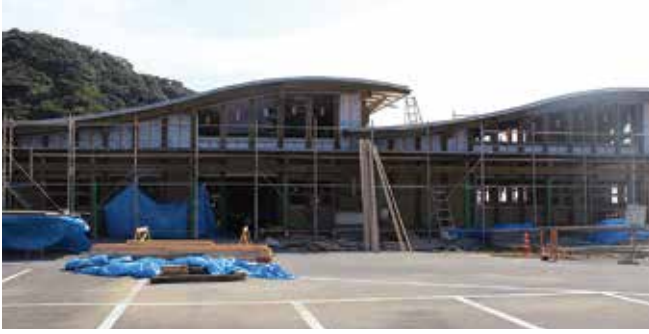
海の駅再開に向けて建設中
