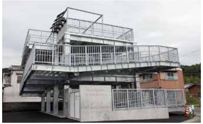
野根地区（磯辺神社裏）防災避難タワー完成
