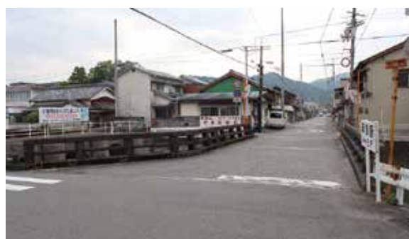
小池橋 耐震化予定
